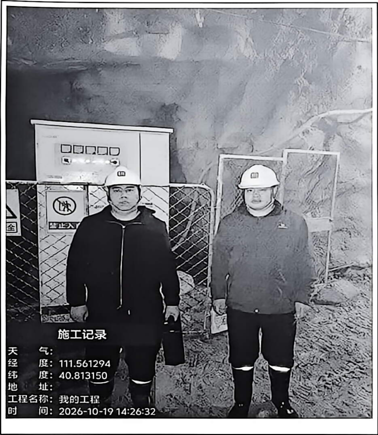
现场检验照片
